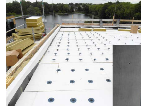
< De invloed van plaatnaden en bevestigers moet worden meegenomen in de berekening van de R_c -waarde.
