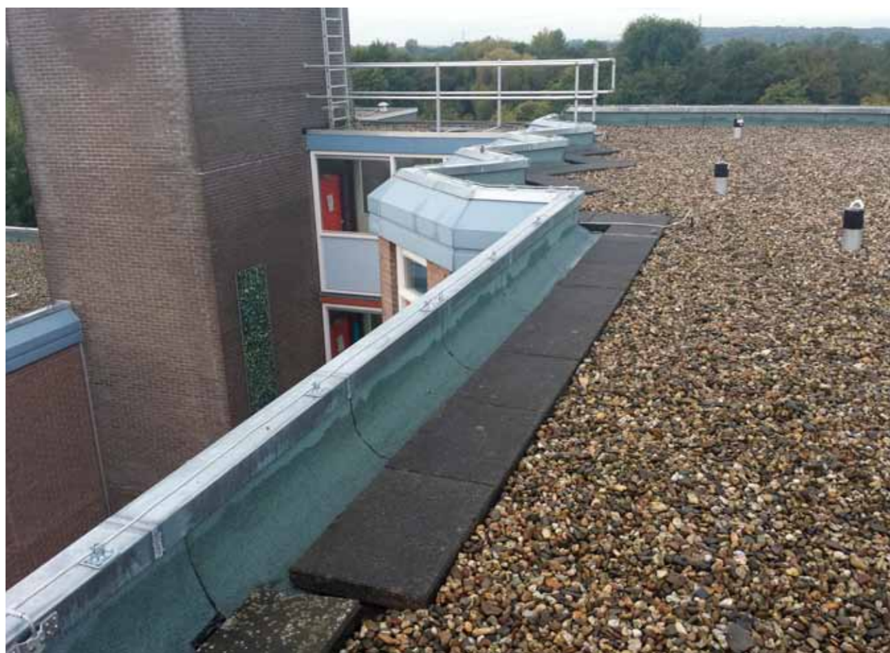
Afgewerkte dakrand met zink: een uitstekende en duurzame afwerking.
